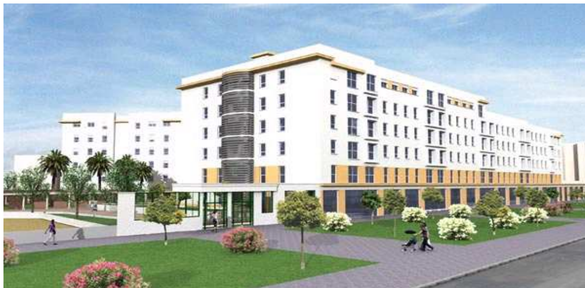
vista fachada locales avda la granja
